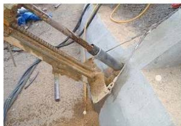
削孔工（二重管穿孔）
