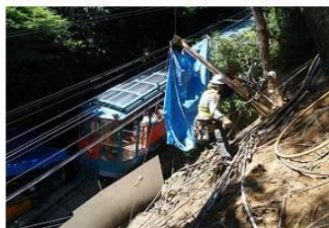
ケーブルカー架線上での施工
