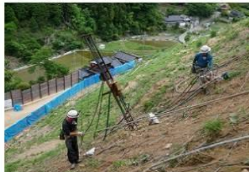
クレーン設置不可法面での施工
