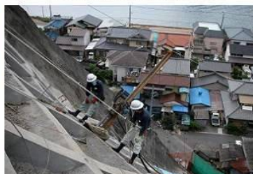
クレーン設置不可法面での施工
